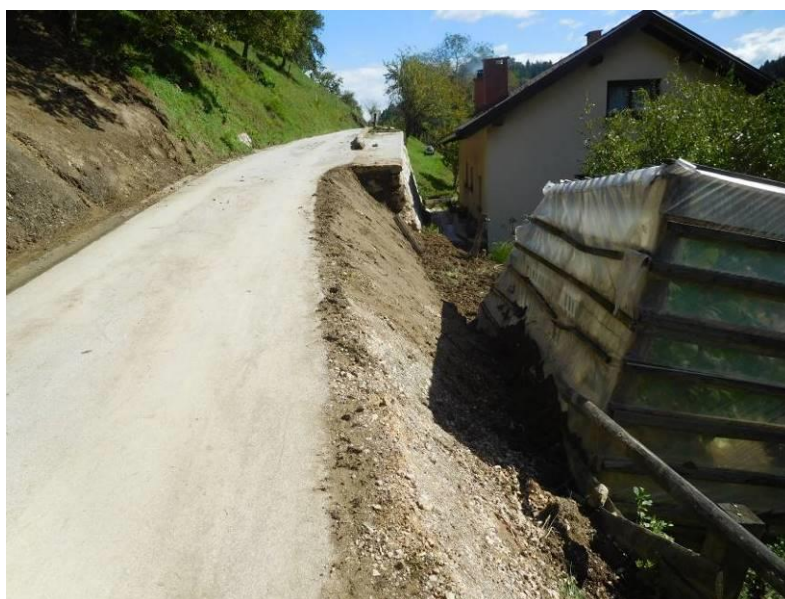
obstoječa podporna konstrukcija in brežina pod LC 490202
