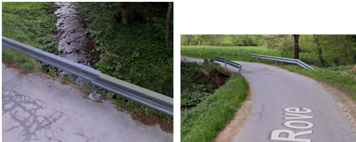
Slika 2, 3: – pogled na mostno konstrukcijo (desno) in gorvodni pogled na strugo potoka (levo).
