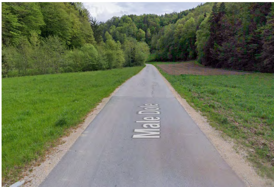
Slika 1: Začetek rekonstrukcije odseka.
