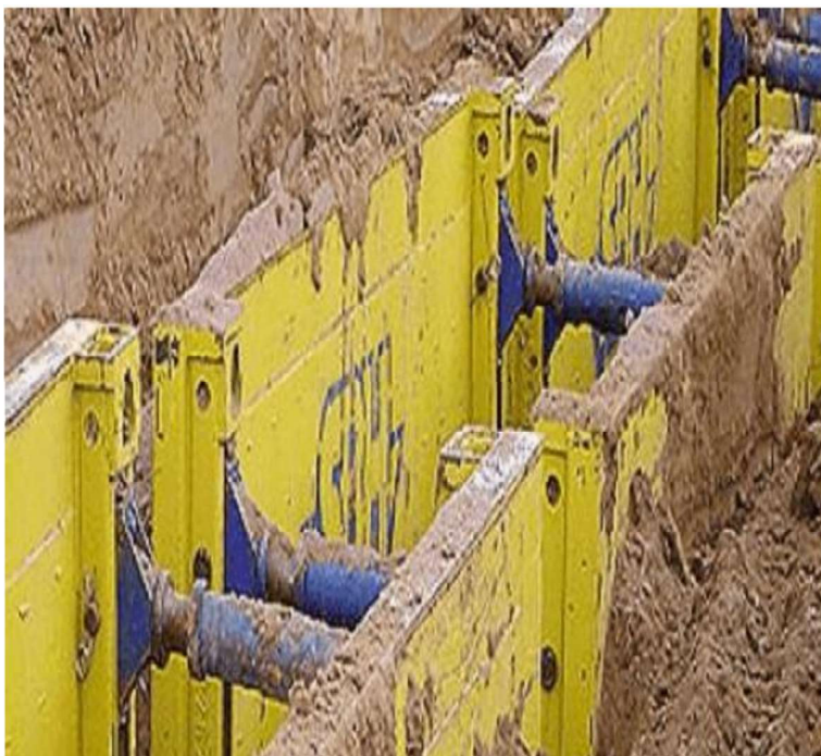
Slika 9 – Opažni sistem SBH za varovanje gradbene jame
