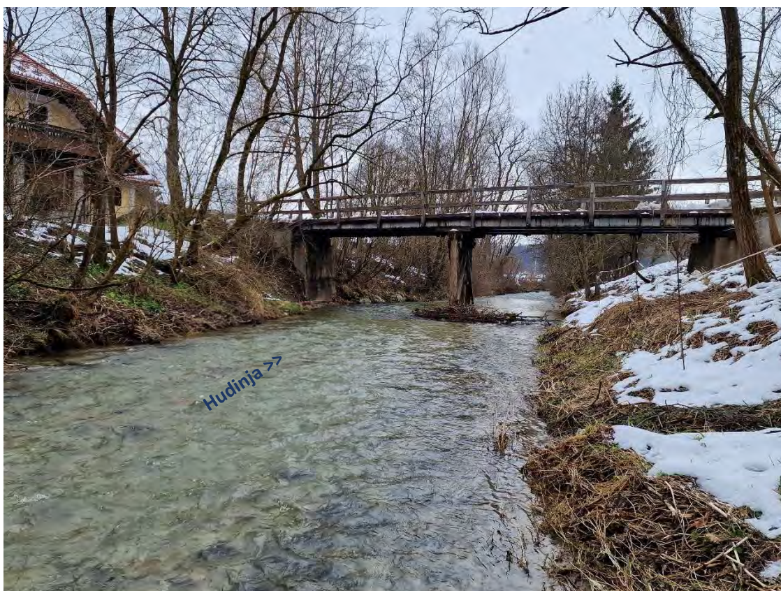
Slika 2: Slika obstoječe ureditve brvi, slikano z desne brežine. Plavje na sredinskem oporniku.
