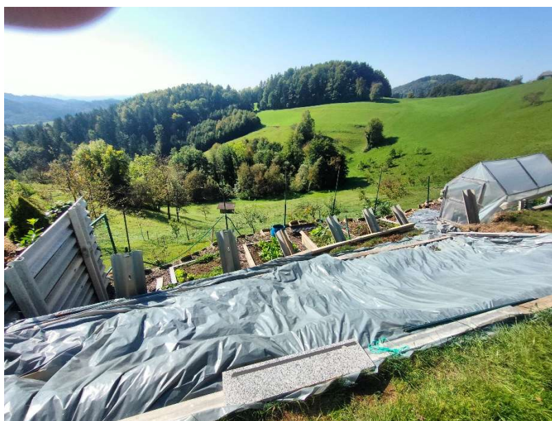
Slika 3: Odlomi rob, tik od stanovanjskem objektu, prekrit s polivinilom za preprečitev zatekanja vode
