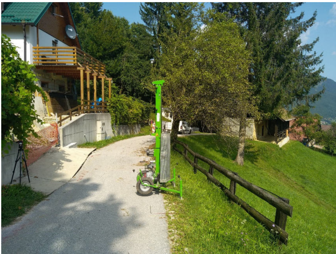
Slika 4 - Predmetna cesta, plaz
