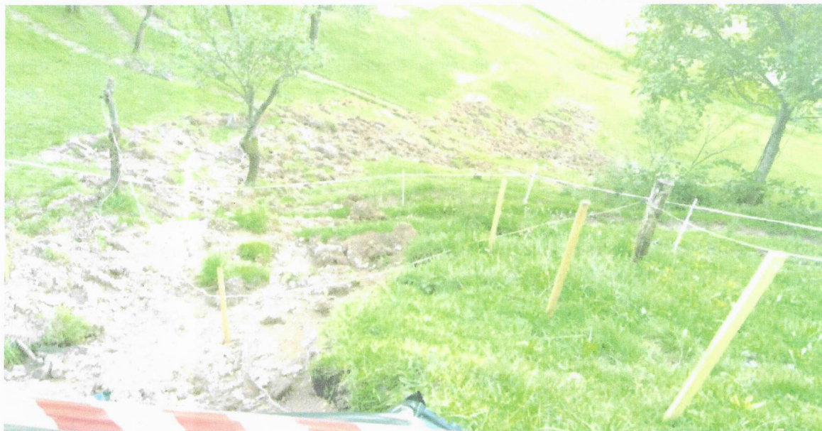
Slika 3 – fotografija splazele zemljine po pobočju
