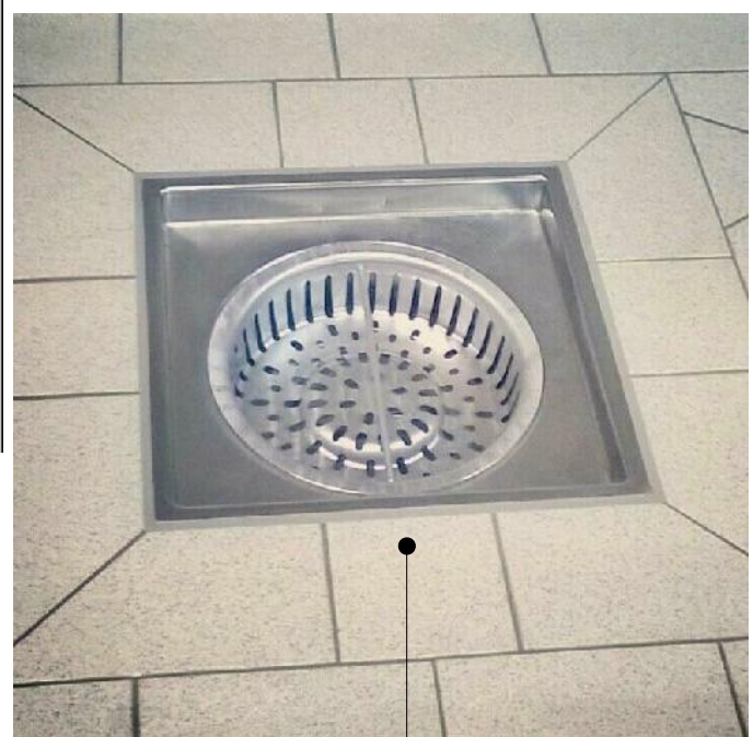
Talna rešetka za to kovno odvodnjavanje. Detail polaganja keramike: Keramiko v oddaljenosti 1m od talne rešetke je potrebno položiti s padcem 1% proti talni
