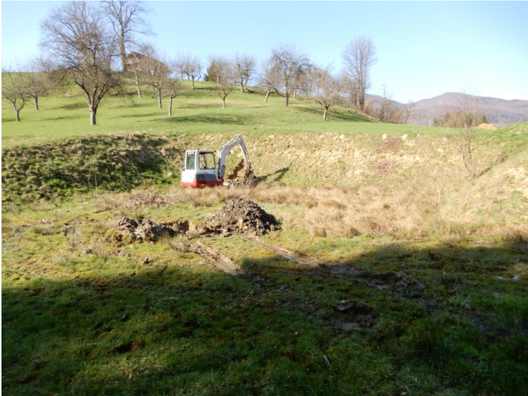
Pogled na območje vkopa v pobočje (Foto 06. 04. 2018)
