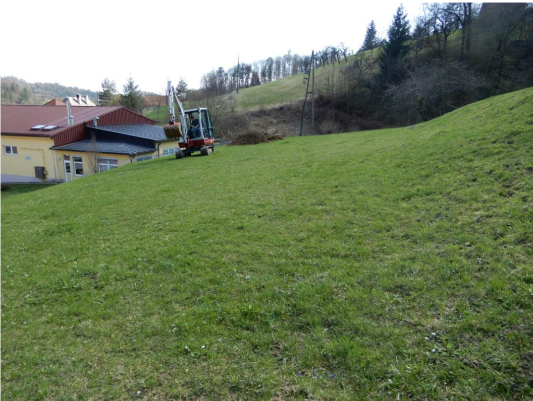
Pogled na območje gradnje s severne strani (Foto 06. 04. 2018)
