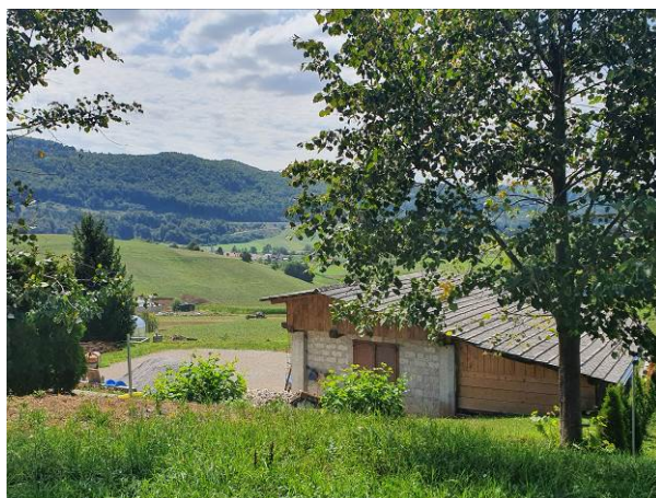
Spremljajoči objekt na zahodni strani
