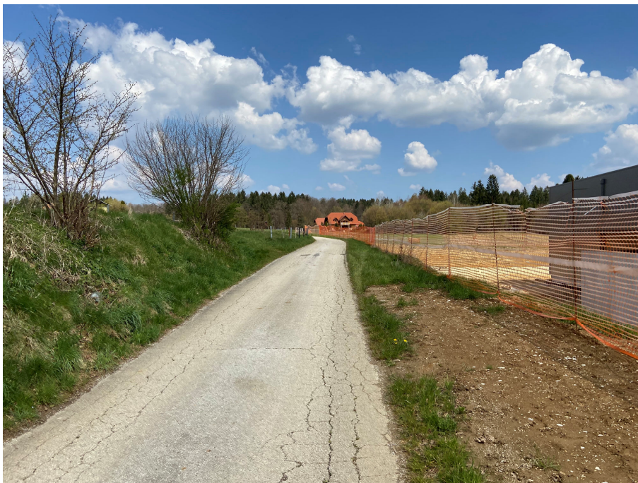
- pogled na cesto Vina Gorica pri podjetju Orkoplast -
