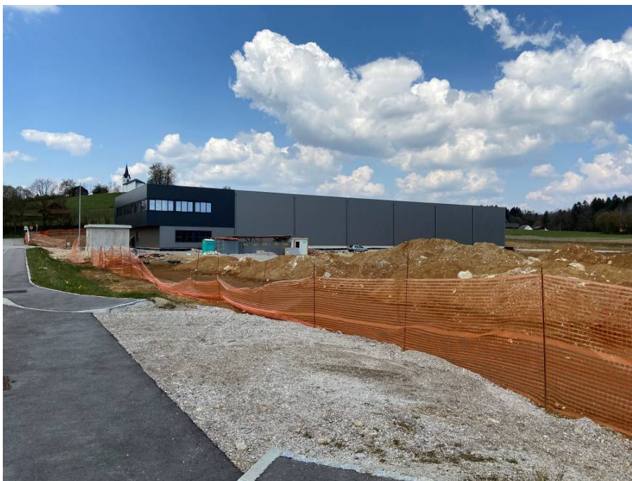
- pogled na gradbišče objekta Orkoplast, v ozadju na vzpetini cerkev Žalostne Matere božje -
