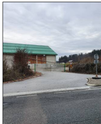
Dostop pri stavbi skladišča
