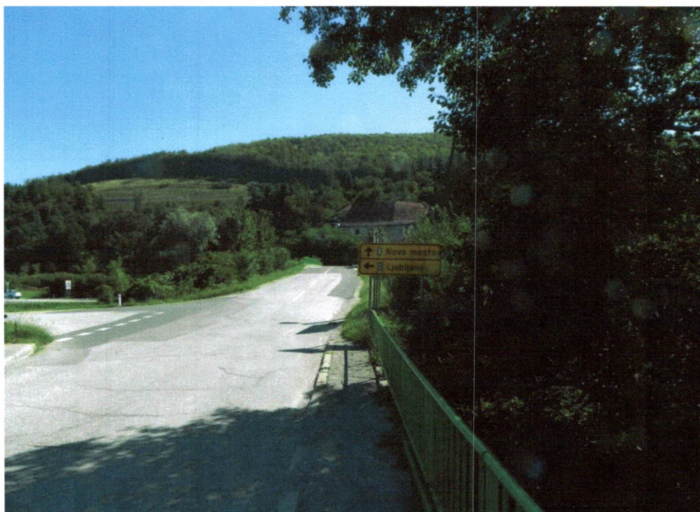
Slika 5: konec rekonstrukcije lokalne ceste km 0.225 oziroma navezava na projekt PZI; št. proj. AP029-17, avgust 2019
