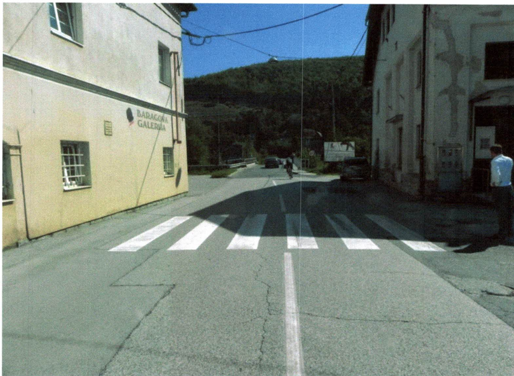
Slika 1: pogled na začetek rekonstrukcije odseka lokalne ceste LC 425052 Trebnje-grad
