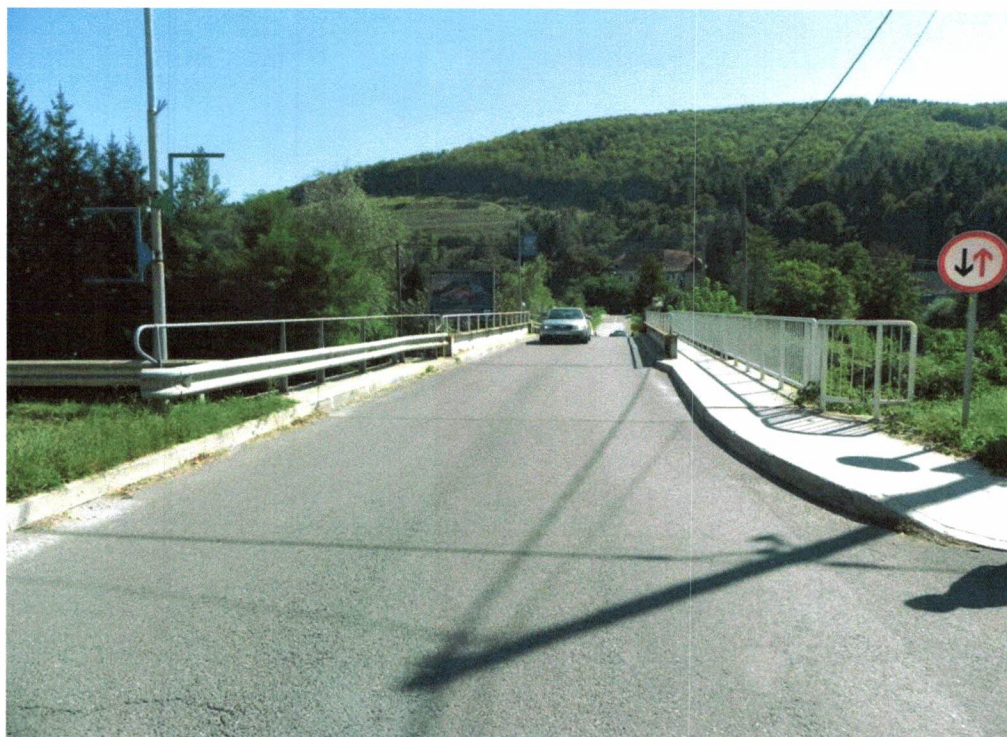
Slika 2: pogled na nadvoz čez železniško progo
