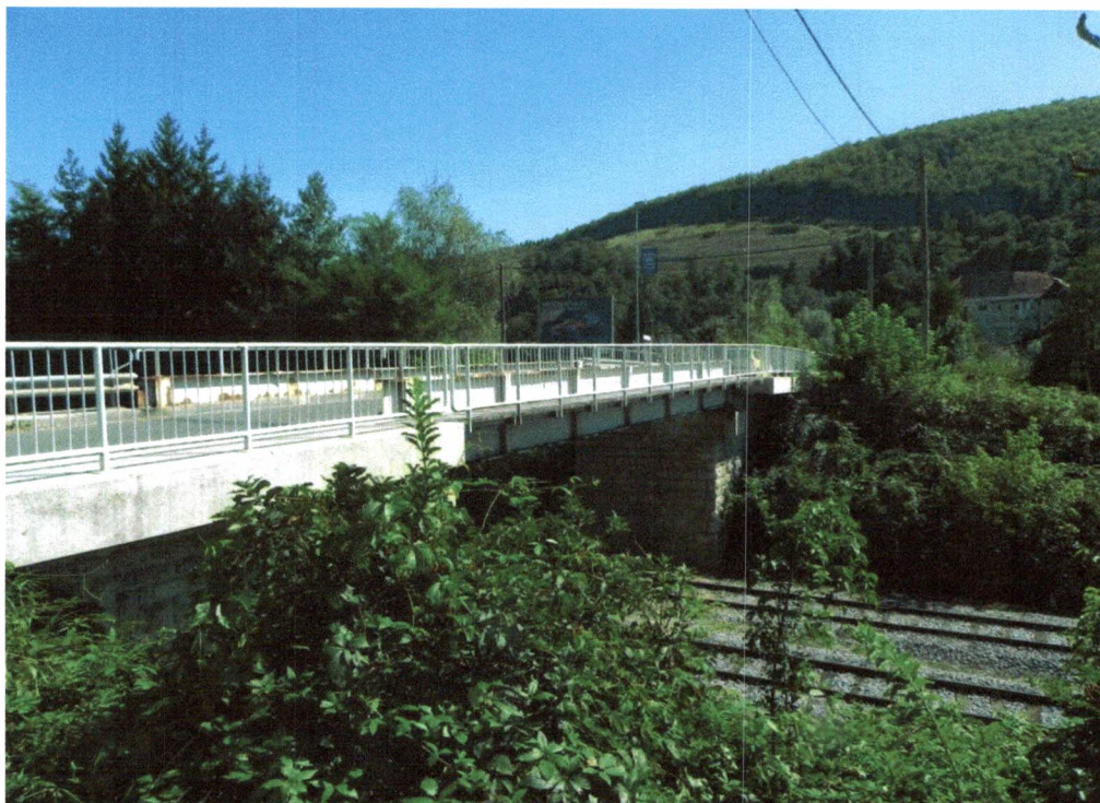
Slika 3: pogled na nadvoz čez železniško progo
