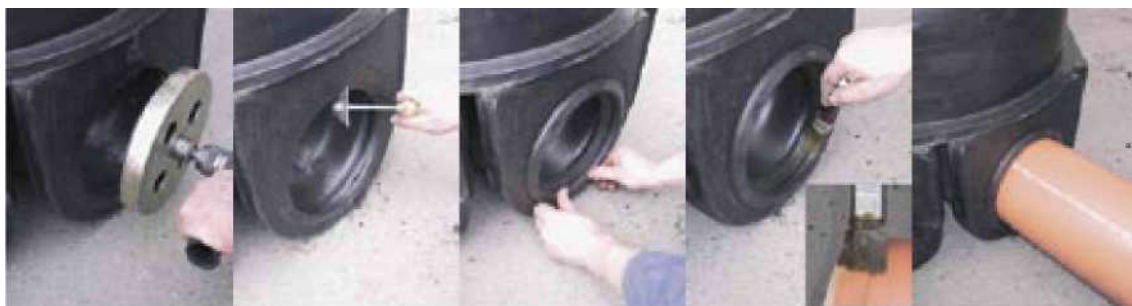
Vrtanje vstopne izvrtine z ustreznim kronske svedrom, adapterjem ročnim vrtnim strojem
