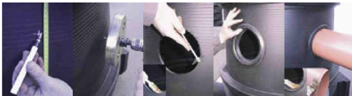
Določitev središčne višine dodatnega priključka
