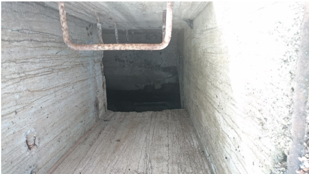
Slika 1 – priklop meteorne kanalizacije na obstoječ RJ
