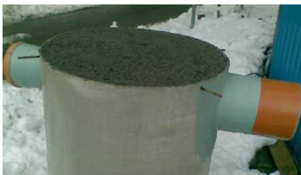
Slika1: Prikazano betoniranje prostora pod muldo.
