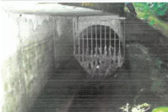
Slika 1 Primer naplavin, ki so zajete na rešetki na iztoku razbremenilne cevi
