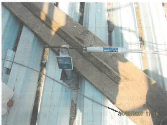
SISTEM VAROVANJA ZA DELO NA STREHI SKLADNO Z SIST EN 795 (NAVEZOVALNA VRV ZA PRIVEZ Z VARNOSTNIM PASOM)
