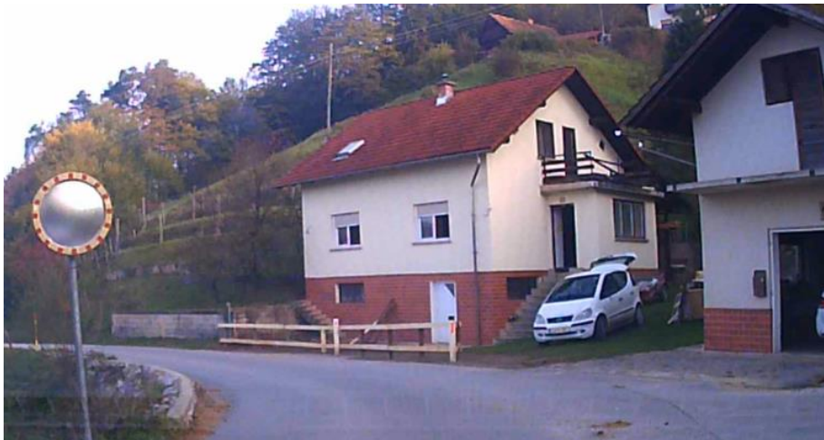
Slika 6: Pogled mesto razširitve krivine in nove kamnite zložbe, pogled v smeri stacionaže.
