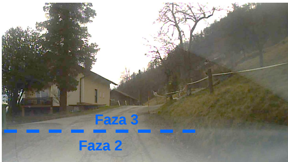
Slika 7: Pogled na mejo med Fazo 2 in Fazo 3 pogled v smeri stacionaže proj. dokumentacije.
