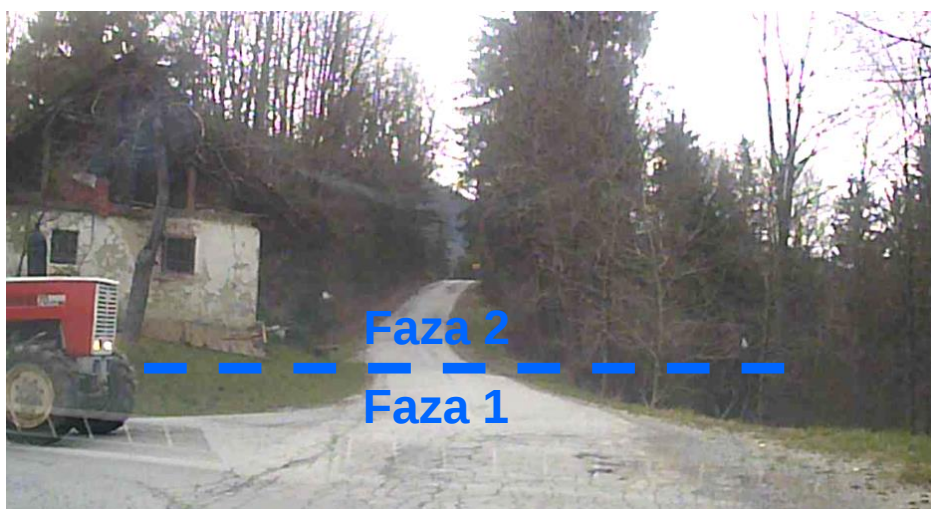
Slika 4: Pogled na mejo med Fazo 1 in Fazo 2 pogled v smeri stacionaže proj. dokumentacije.
