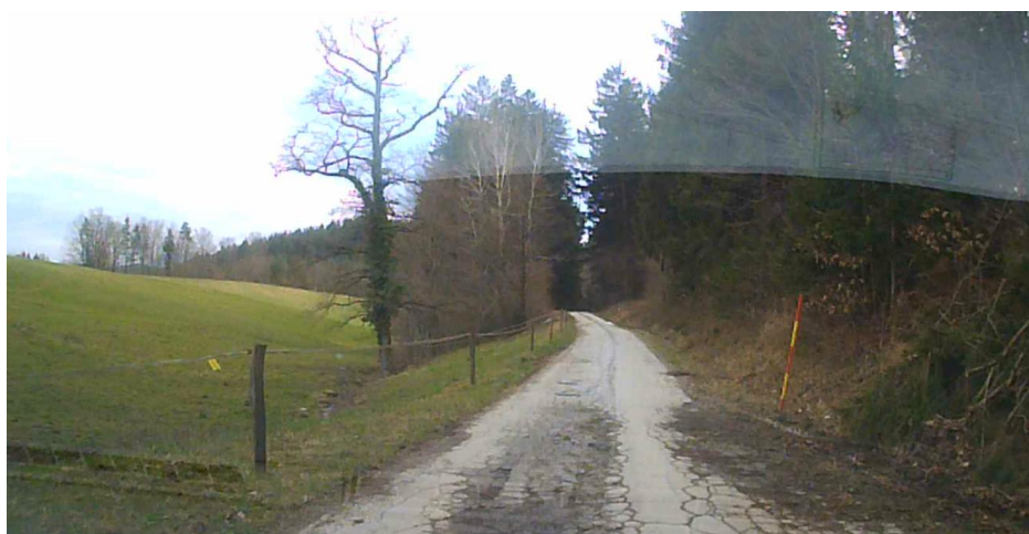
Slika 6: Pogled na osredni del ceste 2.Faze.
