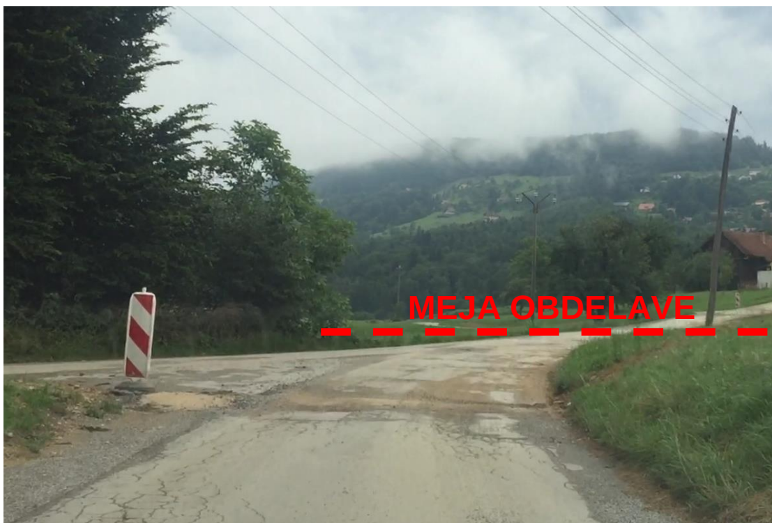
Slika 7: Pogled na konec meje obdelave, pogled v smeri stacionaže.
