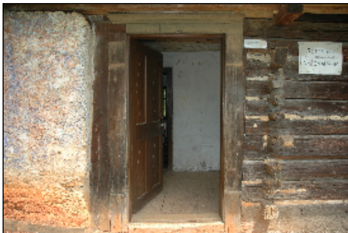
Fotografija št. 11. Vhod ter deli fasade
