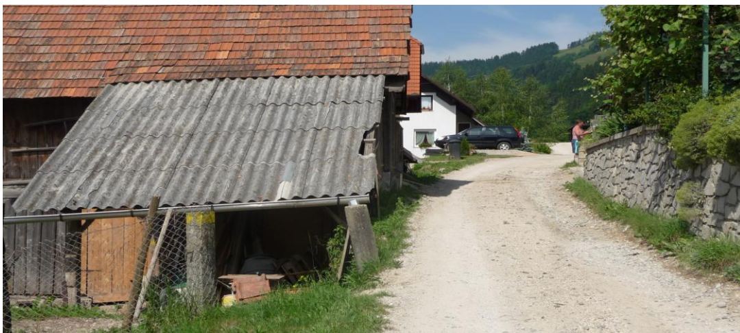
Slika 2: Pogled na obravnavano območje predvidena rušitev objekta levo na sliki - lokacija predvidenga podpornega zidu PZ01
