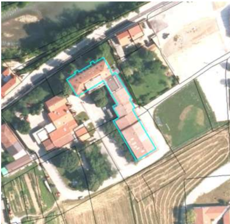
Slika 1; Področje gradnje - obstoječi objekti
