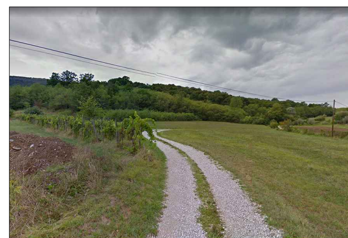
odsek 32 razreda obdelave B: 200m
