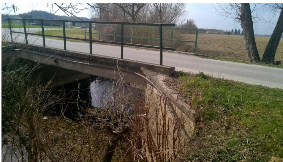
Pogled na most
