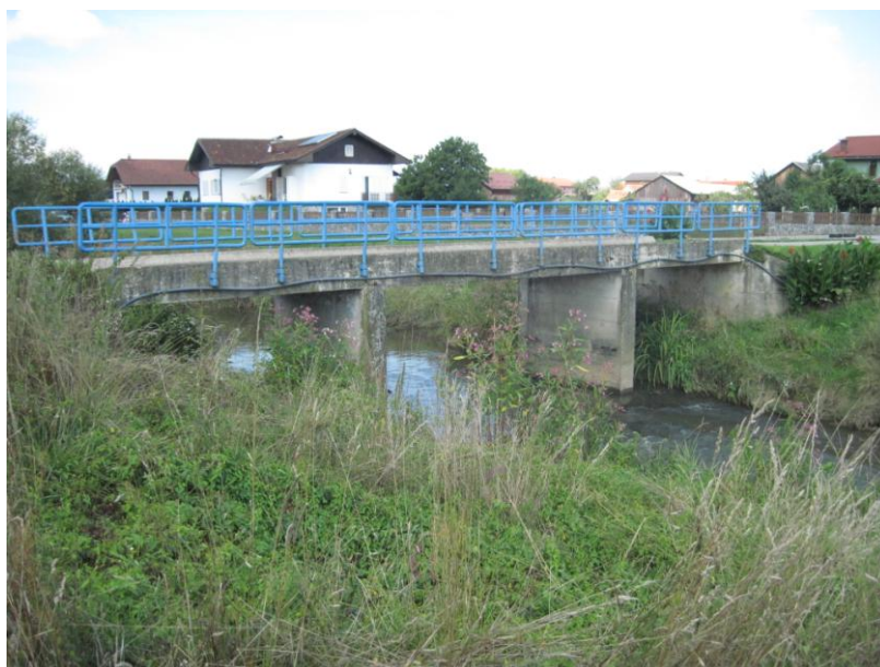
Most z manjšim razponom med rečnimi oporniki, kjer ni možna poglobitev
