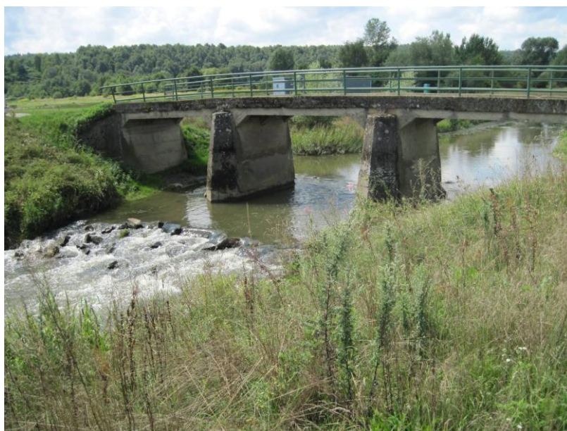
Starejši, pri regulaciji obnovljeni most pri vojaškem poligonu Apače.
