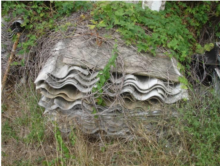
Slika 7 Azbestnocementna valovita kritina ob objektu Vrtojbenska 75 12
