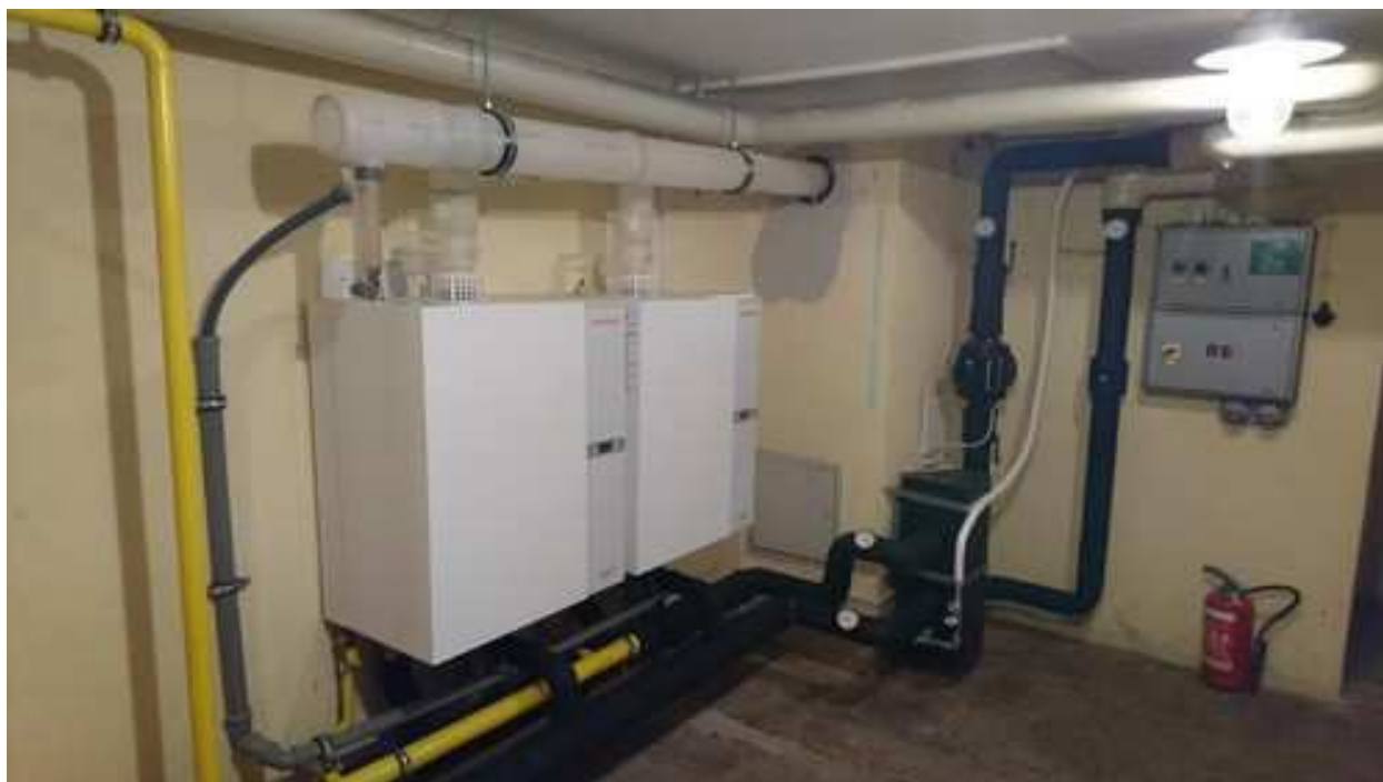
Slika 27: Prenovljena skupna kotlovnica na naslovu Za Žago 1 (vir:Dominvest)
