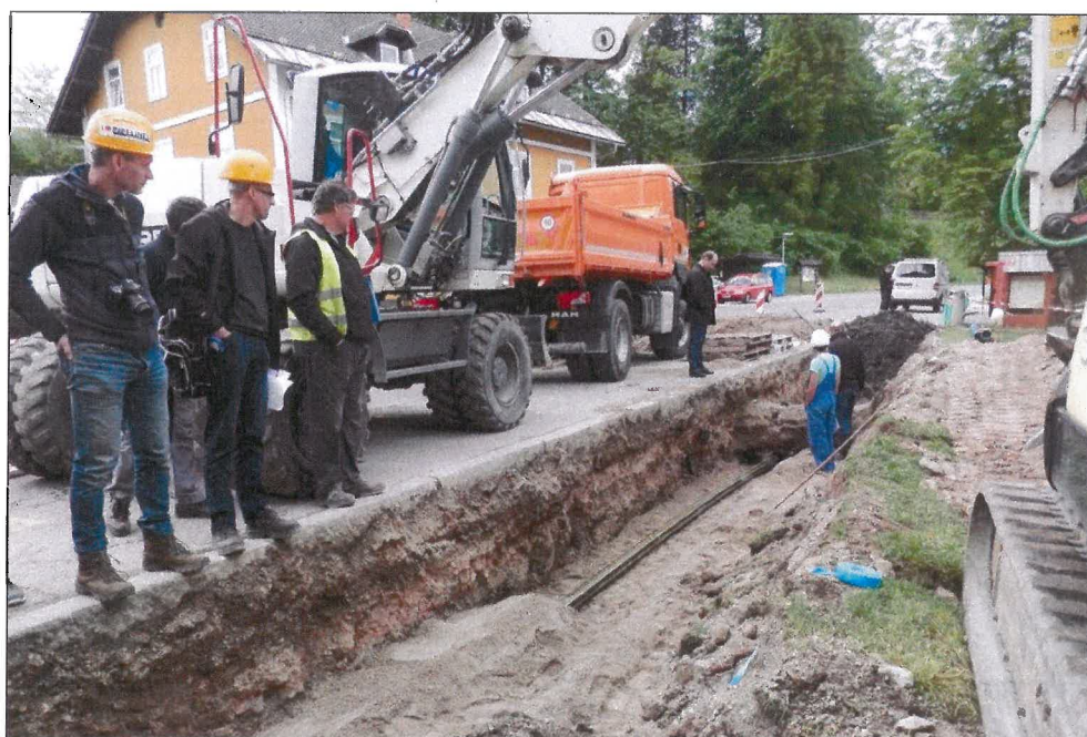
Slika 4: Polaganje podzemnega voda ob regionalni cesti (foto 17.05.2016)
