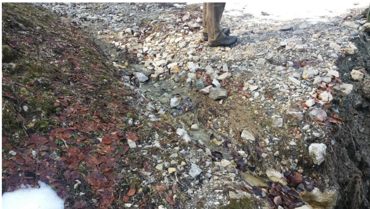
Slika 7: Dotekanje vode s ceste v grapo pod rezervoarjem
