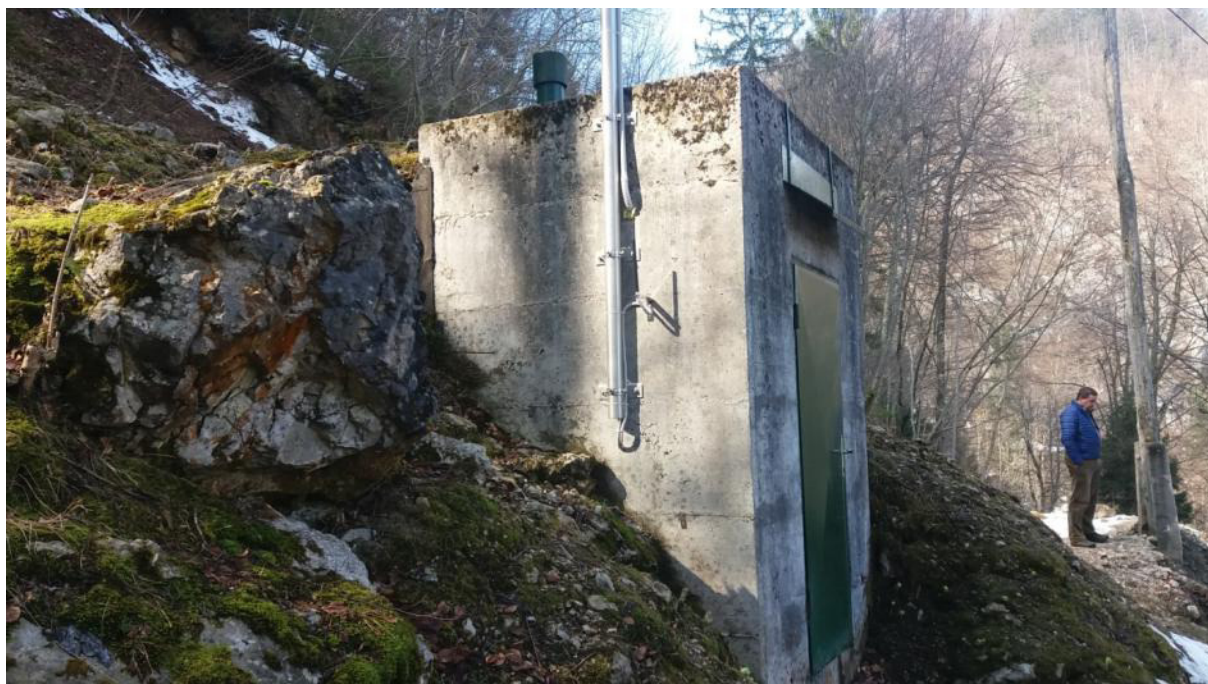
Slika 11: Na samem vodnem rezervoarju ni vidnih poškodb
