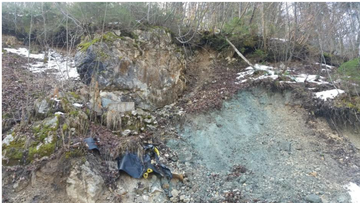
Slika 2: Večji skalni blok nad cesto leži na glini, obstaja velika nevarnost, da bo zdrsnil na cesto ali se celo prekotatil po pobočju navzdol, kar bi lahko ogrozilo tudi hiše v Kupljeniku
