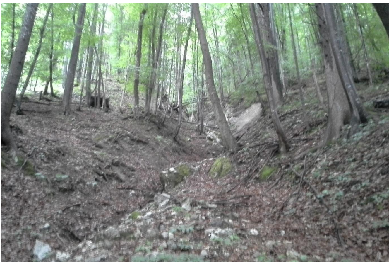
Slika 3: Gorvodni pogled na erodirano strugo hudournika na lokaciji uvajalne pregrade v P6
