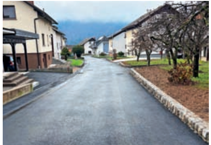
Končana je tudi obnova Dobračevske ulice. Foto: Miha Kavčič
