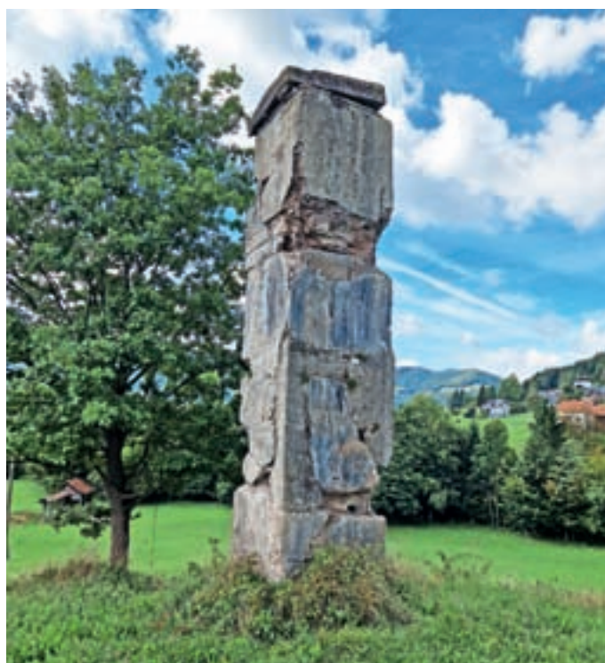
Vodni stolp na Dobračevi Foto: Milan Kopač
