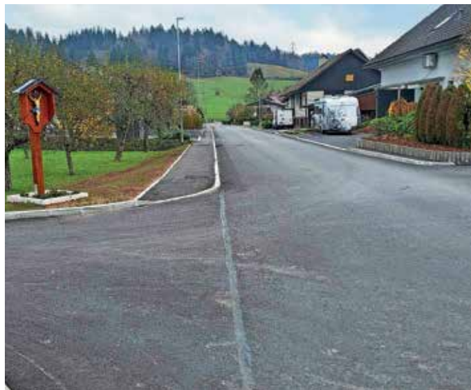
Pred časom so končali tudi obnovo ceste Pod griči.
