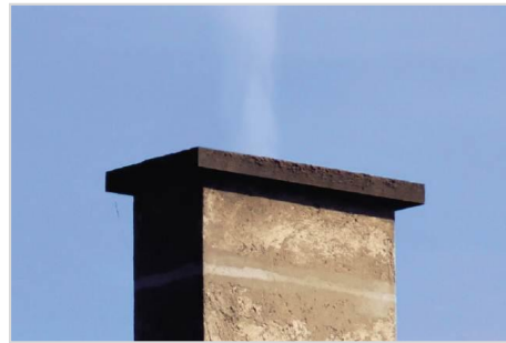
Slika 14; Svetel – neviden dim, razen pare je pokazatelj dobrega zgorevanja, za strokovno presojo so sicer potrebne meritve emisij
