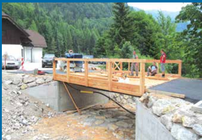
Obnova mostu na Ljubelju
