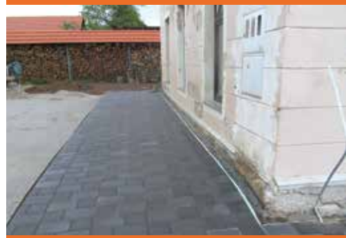
Hidroizolacija objekta POŠ Kovor
