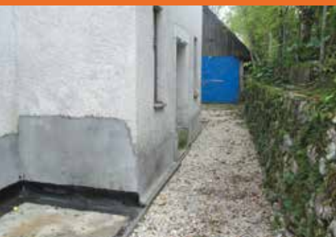
Hidroizolacija v POŠ Leše
