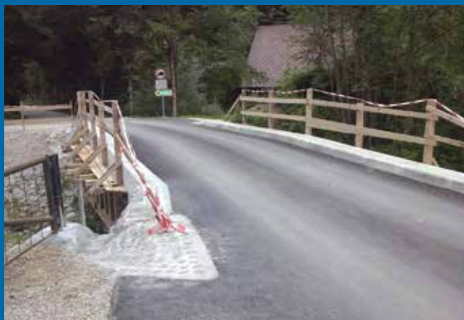
Obnova mostu, ki vodi do Tominčevega slapa
