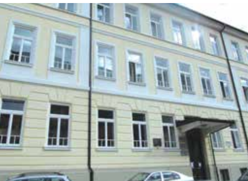
Prenova stavbe na Balosu 4
