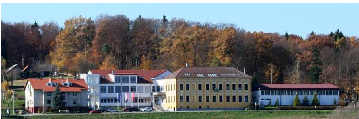
Slika 1: Stavba OŠ Jožeta Hudalesa Jurovski Dol
