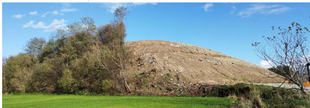
Južno pobočje odlagališča Graščak je očiščeno in pripravljeno na polaganje tesnilnega sloja.
