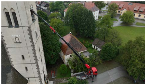
Zvon so na tla spustili s pomočjo posebnega dvigala.
