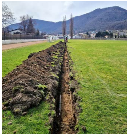
Ena letošnjih večjih naložb na področju športa je bila zamenjava zalivalnega sistema na stadionu na Dobravi.
