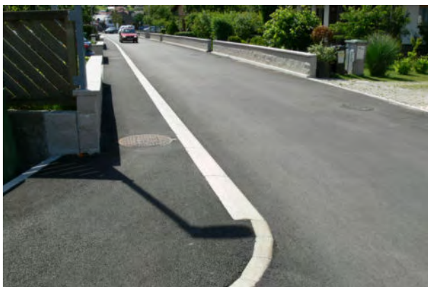
Slika 102: Primerna ureditev za pešce, predvsem za starejše in invalide – nizek robnik, pločnik v eni ravnini
