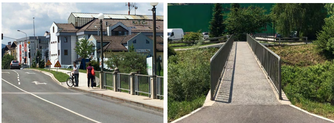
Slika 60: Primer neurejenega cestne mostu na Ronkovi ulici ter kolesarske brvi pri Kuharjevem parku (širine 1,5 m)
