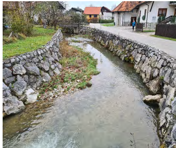
Slika 13: Kamnitobetonski zid gorvodno od Mostu 5 (pogled dolvodno)
