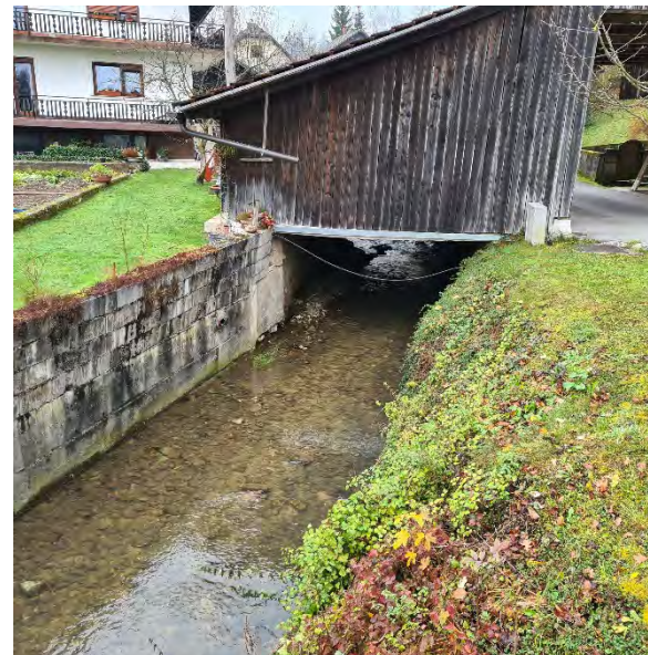
Slika 5: Objekt 1-dolvodni odsek s kmetijskim objektom na mostni konstrukciji
