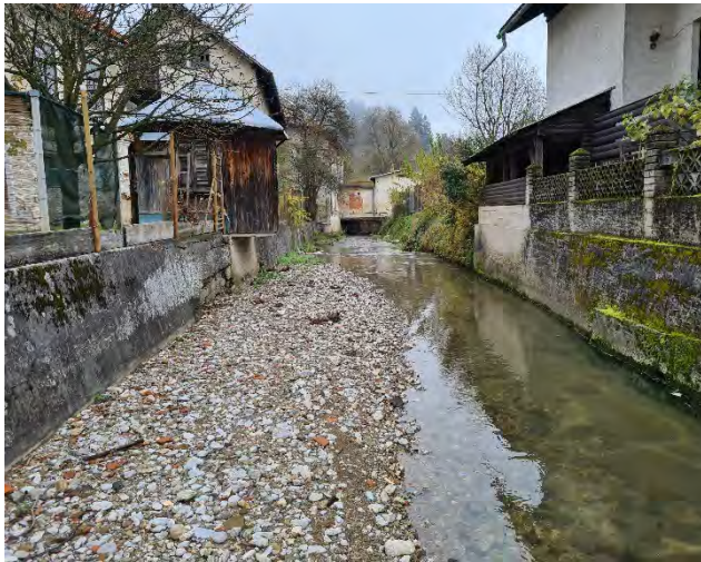
Slika 14: Struga dolvodno od Mostu 5 z odloženim materialom
