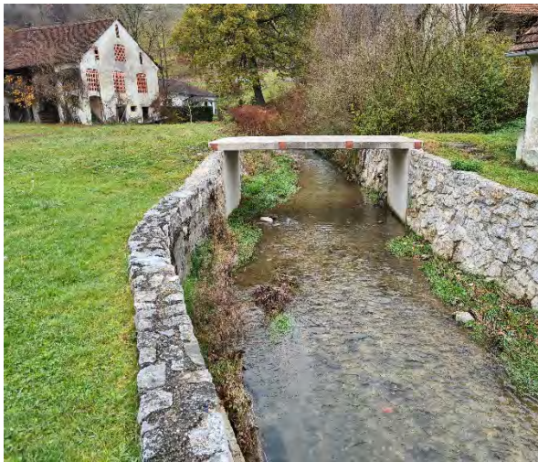
Slika 12: Most 4-pogled gorvodno
