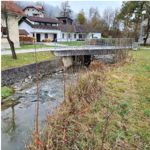
Slika 10: dolvodni pogled na most 3
