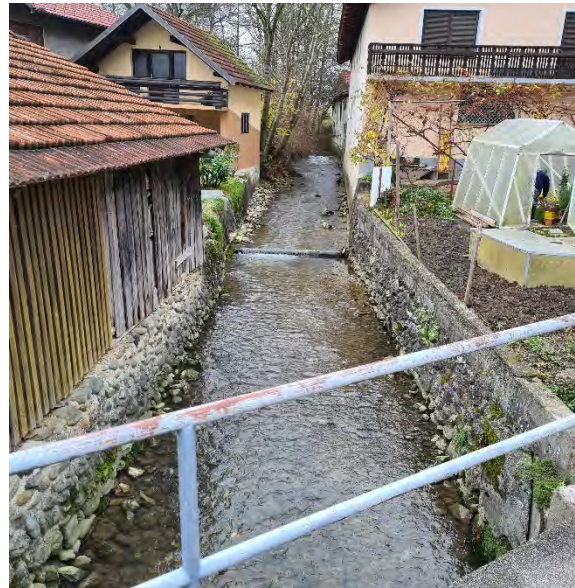
Slika 3: Most 1-pogled gorvodno
