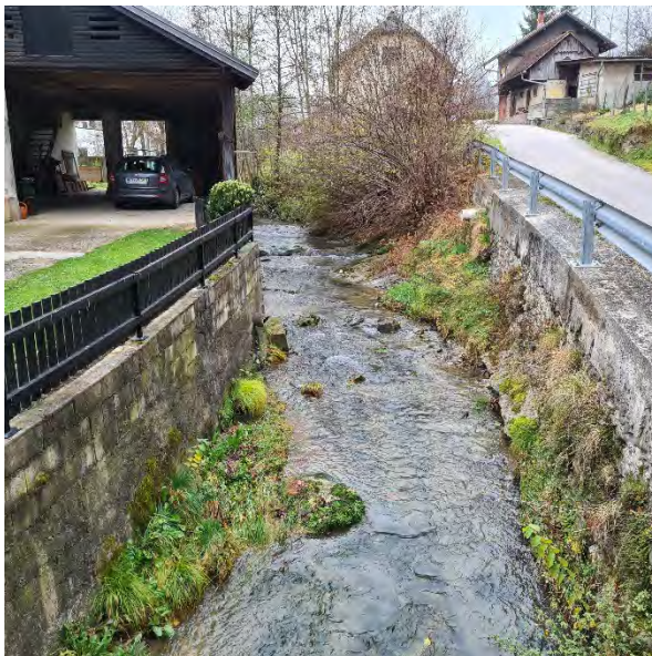
Slika 4: Območje struge gorvodno od Mostu 2
