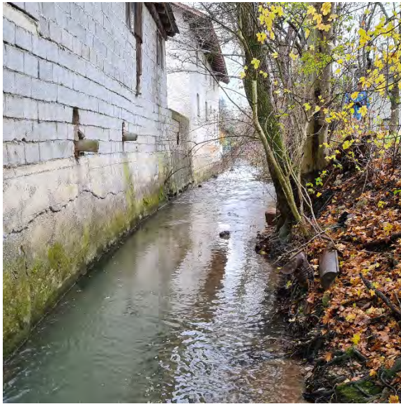
Slika 2: Območje struge na začetku obravnave ob kmetijskem objektu
