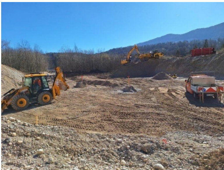
Slika 10: Gradnja komunalne opreme OLN za čistilno napravo
