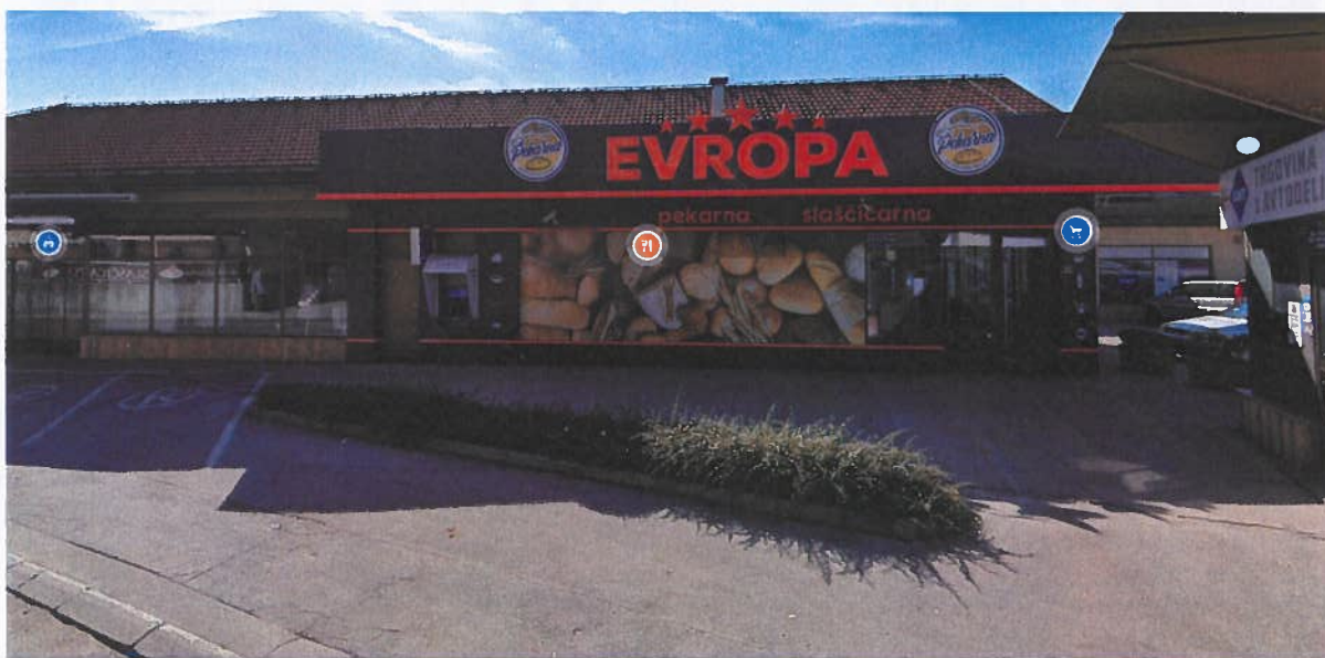
Sliki 3 in 4: Primerjava izgleda obstoječe stavbe in posega pekarne Evropa na severni fasadi stavbe. Na sliki se jasno vidi, da poseg pekarne ne spoštuje obstoječih gabaritov stavbe, tako tlorisnih in kot tudi višinskih.
