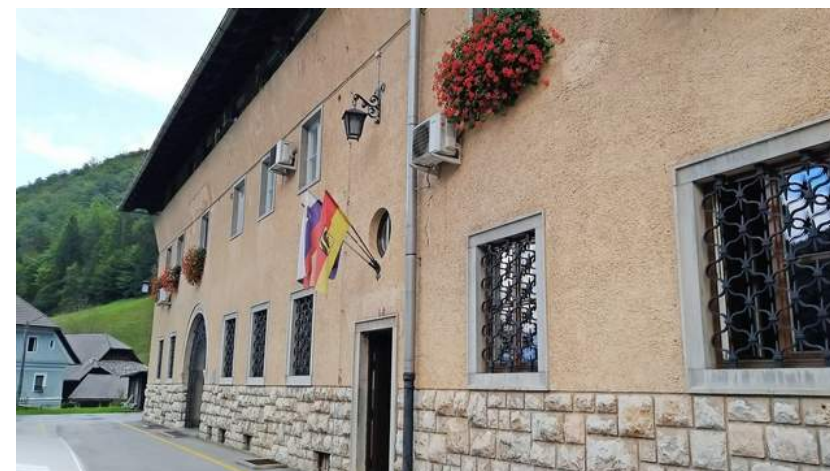
Obnova kulturnega doma v Kropi
