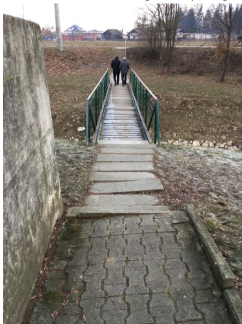
Slika 17: Prikaz neustreznega dostopa za gibalno ovirane osebe
