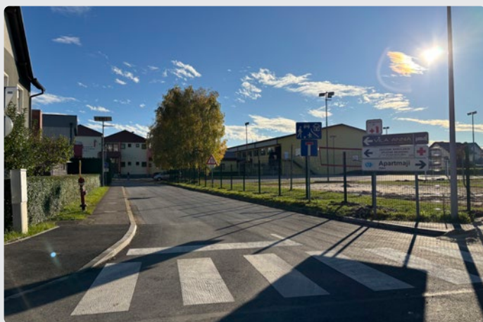
Slika 5: Urejen prehod za pešce s spuščnim robnikom na Mladinski ulici v Radencih z vertikalnim prometnim znakom, ki označuje območje umirjenega prometa
