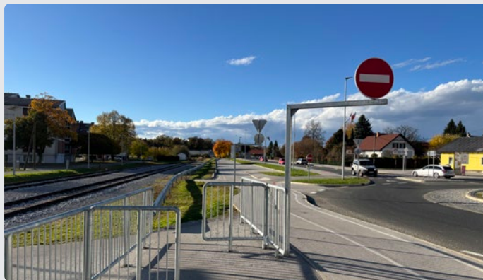
Slika 14: Zavarovan prehod za pešce ob železniških tirih z jekleno ograjo in vertikalno prometno signalizacijo, postavljeno tako, da ne posega v prometni profil pešca ali kolesarja
