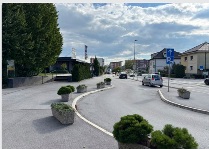
Slika 38: Urejene površine za mirujoči promet v središču Radencev z enosmernim prometom in postavljenimi koriti, ki preprečujejo nenadzorovano parkiranje na površinah za pešce
