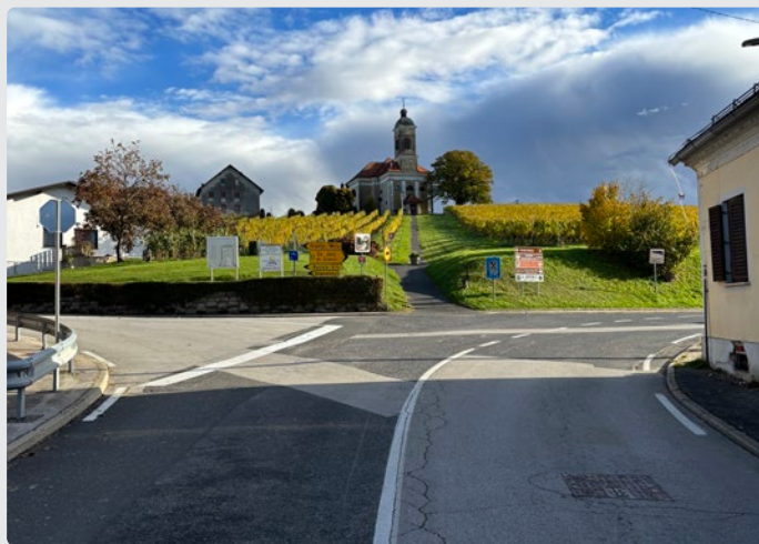
Slika 41: Nepregledno križišče na državni cesti RT-941/1541 Grabonoš-Radenci v naselju Paričjak
