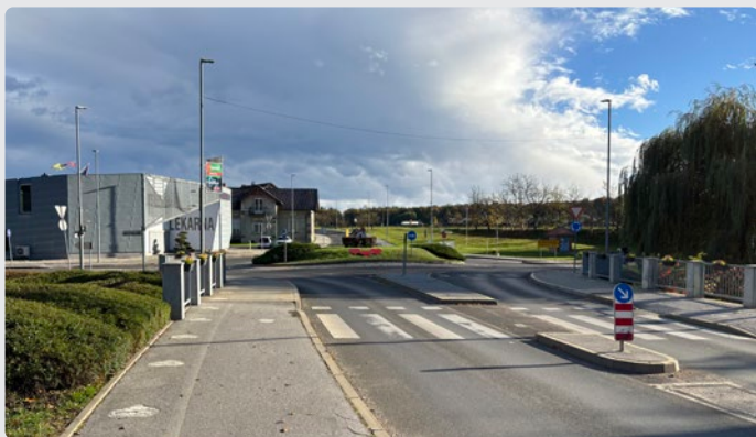
Slika 15: Ustrezen urejen prehod za pešce v križišču s krožnim prometom na Radgonski cesti v Radencih in s srčki označena varna šolska pot na deniveliranem hodniku za pešce
