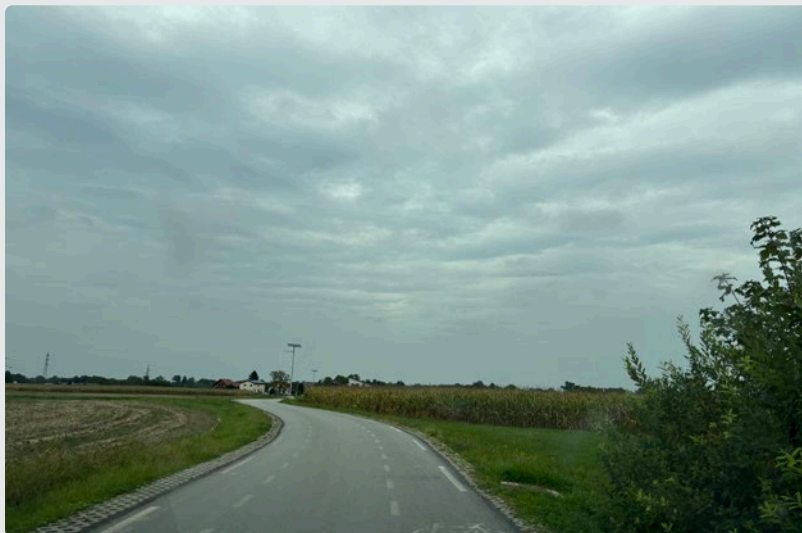
Slika 25: Obojestranski kolesarski pas na lokalni cesti JP-844721 Šratovci–Boračeva z bankino, utrjeno s tlakovcem, ki umirja motorizirani promet ter daje več prostora kolesarjem in pešcem
