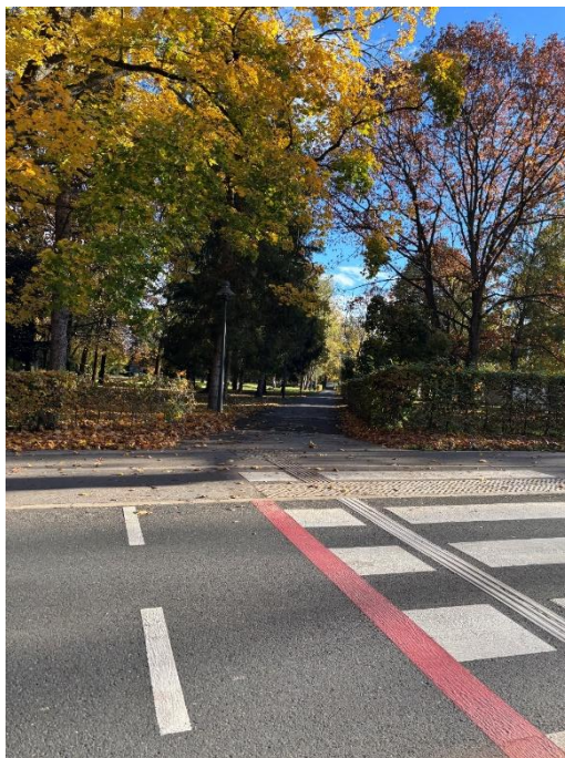
Slika 11: Deniveliran prehod za pešce s taktilnimi označbami za slepe in slabovidne na Panonski cesti v Radencih, ki povezuje zdraviliško naselje s Cankarjevo ulico in zalednim stanovanjskim naseljem ter umirja promet ob vstopu v središče naselja
