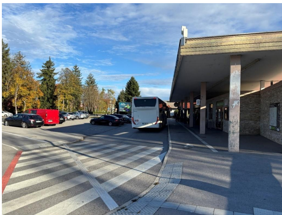
Slika 29: Avtobusna postaja v Radencih z urejenim vhodom s prehodom za pešce in kolesarje (s taktilnimi označbami za slepe in slabovidne) ter deniveliranim, pokritim peronom, ki se zlije s hodnikom za pešce. Na levi strani urejeno parkirišče za mirujoči promet
