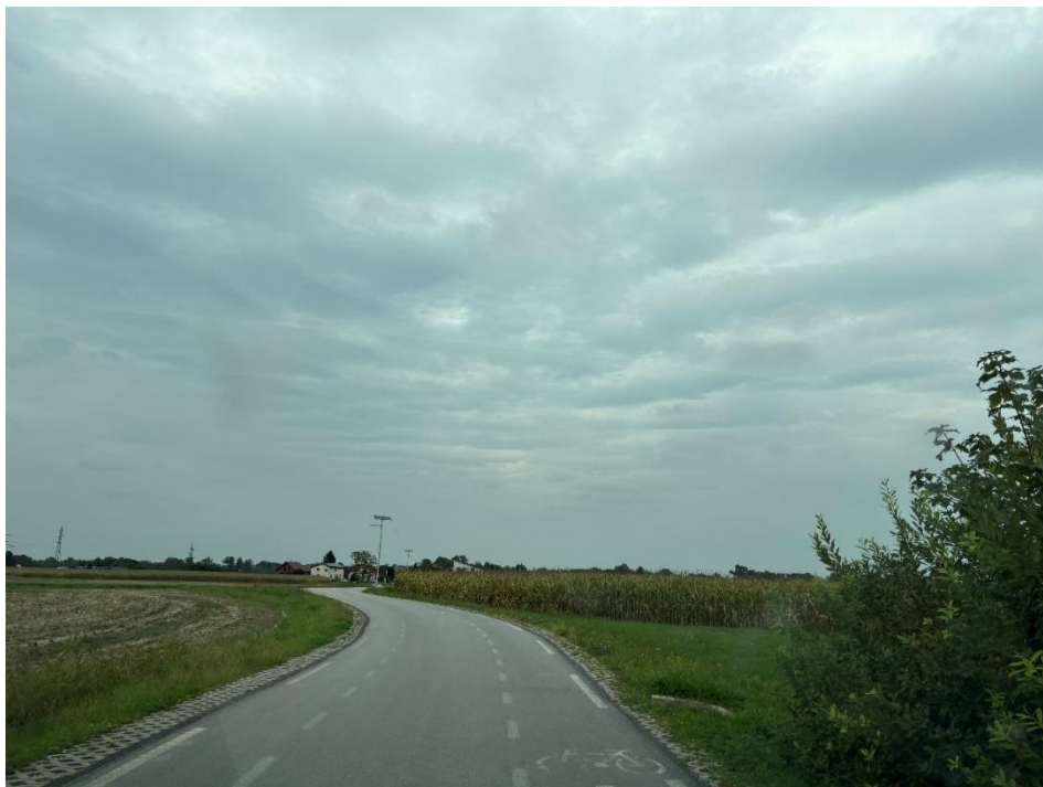
Slika 24: Obojestranski kolesarski pas na lokalni cesti JP-844721 Šratovci-Boračeva z bankino, utrjeno s tlakovcem, ki umirja motorizirani promet ter daje več prostora kolesarjem in pešcem
