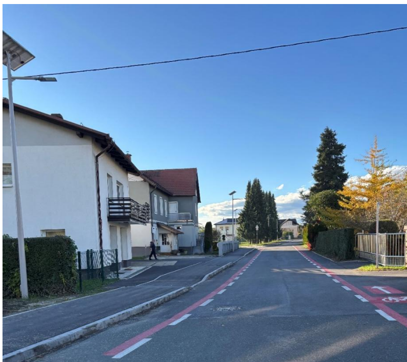
Slika 21: Obojestransko zarisani kolesarski pasovi na Mladinski ulici v Radencih, ki zožuje vozišče za motorizirani promet in posledično zmanjšuje hitrost vozil
