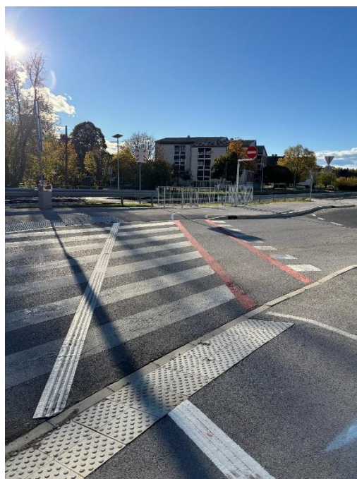
Slika 12: Prehod za pešce s taktilnimi označbami za slepe in slabovidne na Radgonski cesti, na vhodu na avtobusno postajo Radenci
