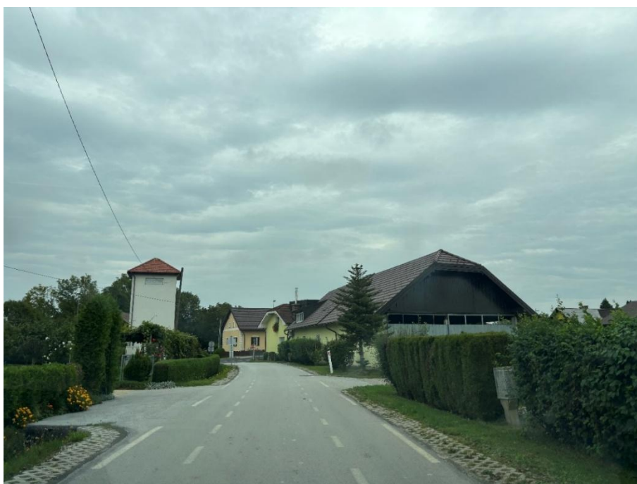
Slika 44: Urejeni obojestranski kolesarski pas na lokalni cesti JP-844721 Šratovci-Boračeva, ki zooža prometni profil motoriziranemu prometu, posledično pa zmanjša tudi njegovo hitrost in daje več prostora trajnostnim oblikam mobilnosti
