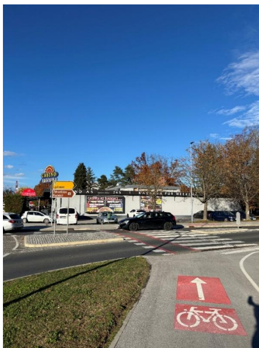
Slika 22: Urejen prehod za kolesarje s piktogrami na kolesarskem pasu ob Radgonski cesti v Radencih
