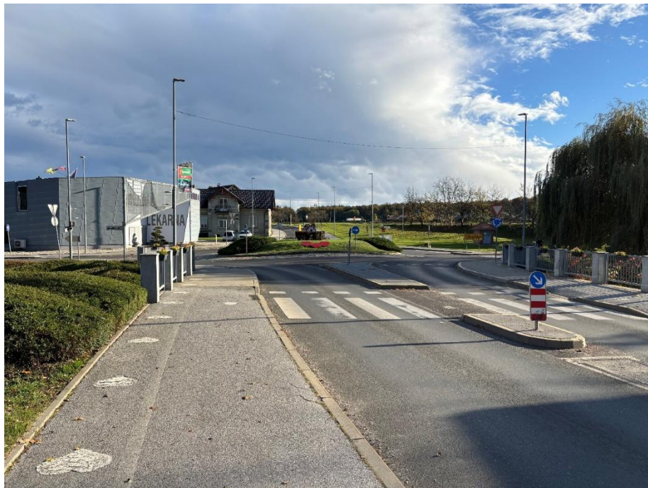
Slika 14: Ustrezno urejen prehod za pešce v križišču s krožnim prometom na Radgonski cesti v Radencih in s srčki označena varna šolska pot na deniveliranem hodniku za pešce
