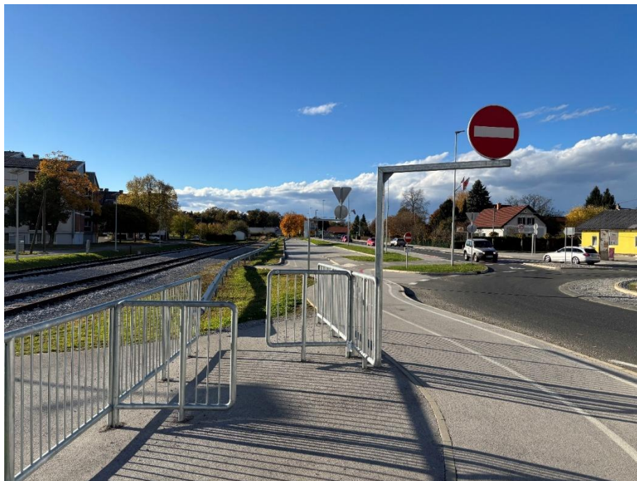
Slika 13: Zavarovan prehod za pešce ob železniških tirih z jekleno ograjo in vertikalno prometno signalizacijo, postavljeno tako, da ne posega v prometni profil pešca ali kolesarja
