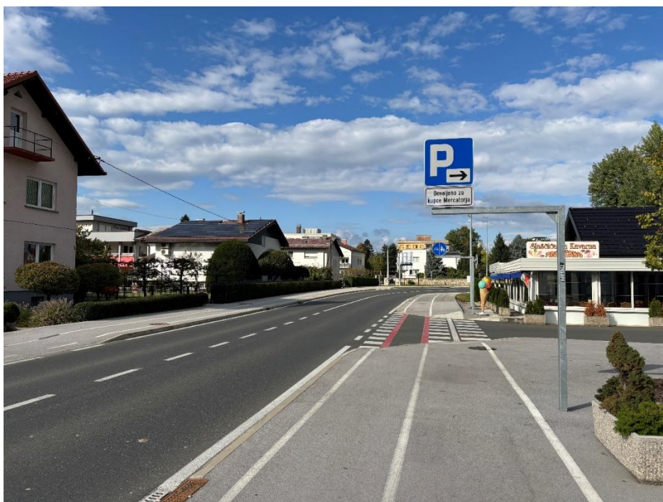
Slika 8: Urejen deniveliran pločnik ob Panonski cesti v Radencih z ločilnimi črtami, ki jasno označujejo površine za pešce in kolesarje, pri čemer prometni znaki ne posegajo v prometni profil pešca
