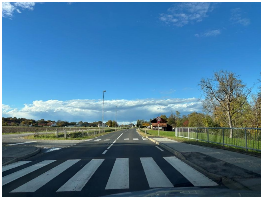
Slika 15: Urejen prehod za pešce na državni regionalni cesti R1-230/1308 Radenci-Vučja vas za varno in vodeno prečkanje ceste
