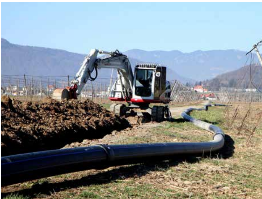
▲ Pri obnovitvi namakalnega sistema Breg pri Polzeli
