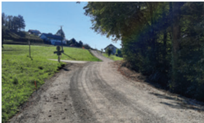
Predvideni konec obnovitvenih del je v oktobru 2023.
