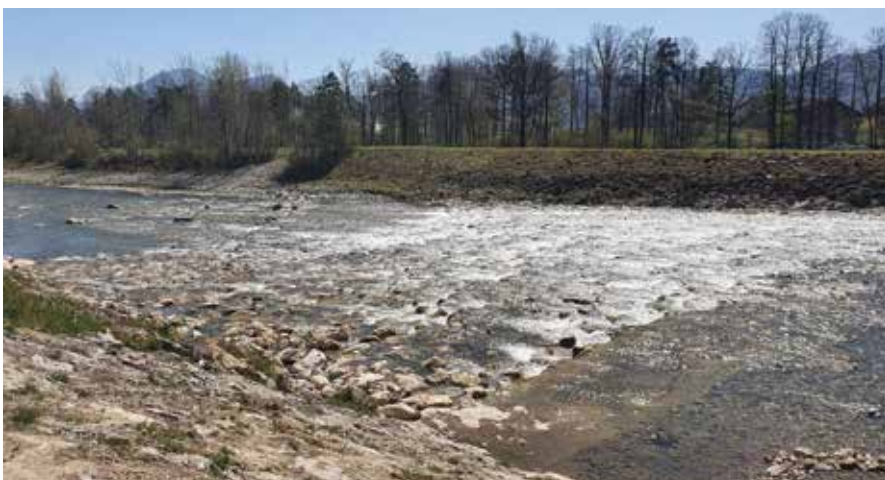
Kamnita drča v Ločici se nahaja dolvodno od križanja Savinje z avtocesto.
