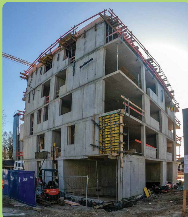
Nadaljuje se gradnja večstanovanjskega objekta ob Šegovi ulici, pod katerim bo tudi garažna hiša. Urejenih bo 20 oskrbovanih najemnih stanovanj, ki predstavljajo prve tovrstne bivalne enote za starejše v Novem mestu.
